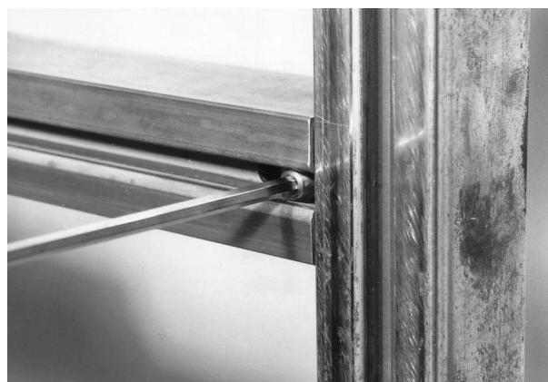
Serrer la vis de blocage dans le montant installé en position
