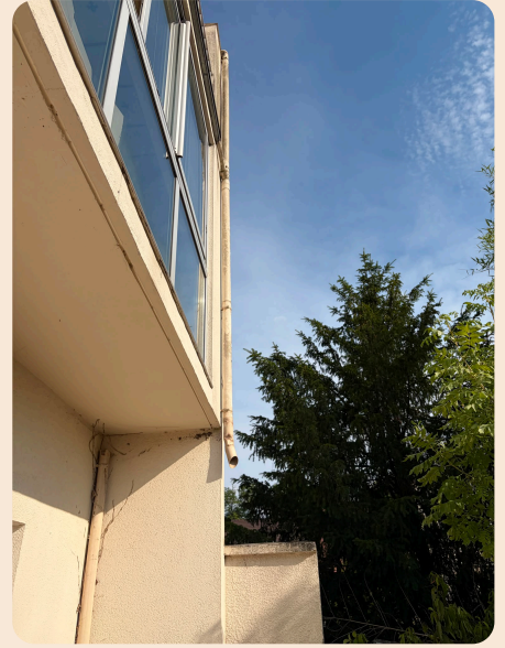
Après (avec réalisation d'un coude)
