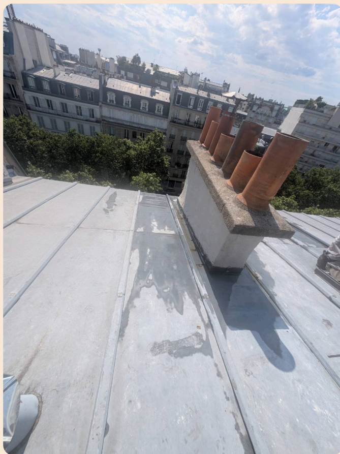
Reprise au mortier
