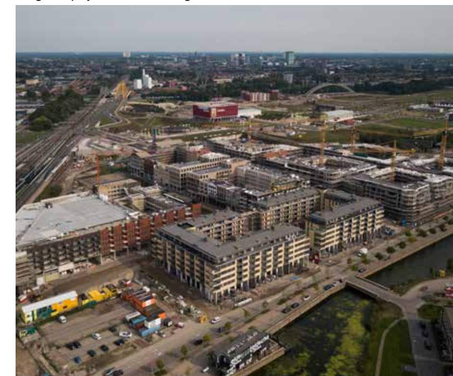
Het gehele project vanuit de lucht gezien
