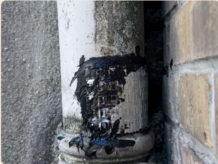
Pose d'une bande d'étanchéité bitumineuse soudée à chaud
