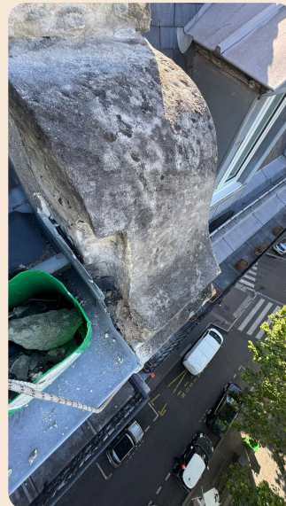
Pendant la purge
