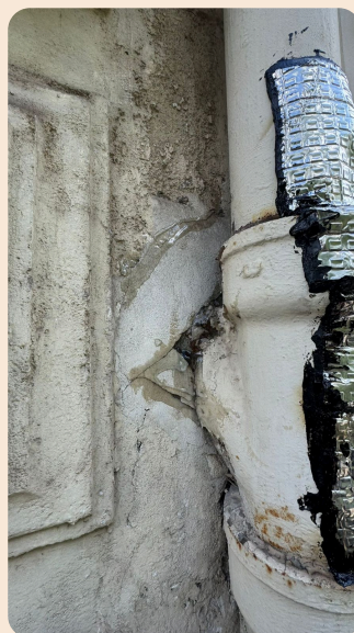
Après mesures: joints mastics + bande armée bitumineuse + bande d'étanchéité à froid pour arrière de descente
