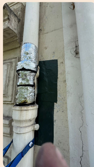
Après: Après mesures: joints mastics + bande armée bitumineuse + bande d'étanchéité à froid pour arrière de descente
