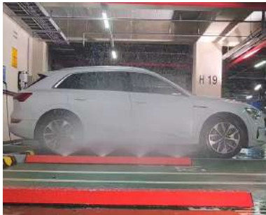
하부스프링클러 작동으로 배터리 냉각 및 화재 확산 방지
