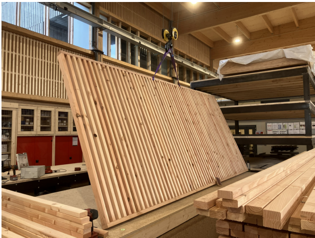
☒ Préfabrication des panneaux en atelier
