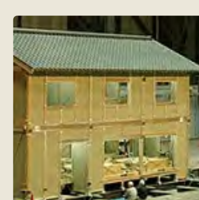
伝統木造設計法構築に向けて、実物大実験！
