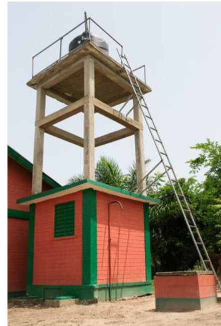
| 80 | Wasserturm neben der Kooperative.
