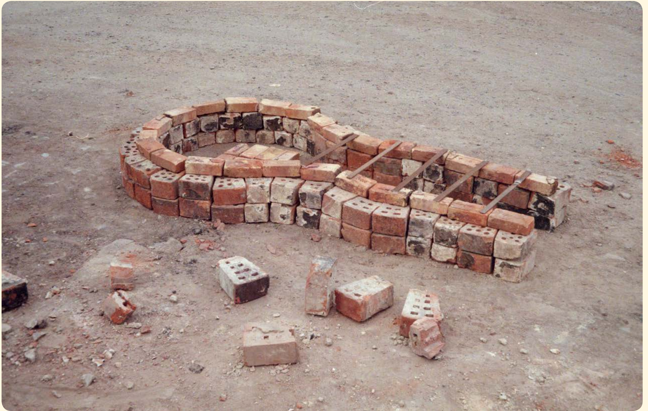
Construction d'un four avec les anciennes briques de la cheminée de l'ancienne briqueterie de Deùlémont © Paul Ralu
