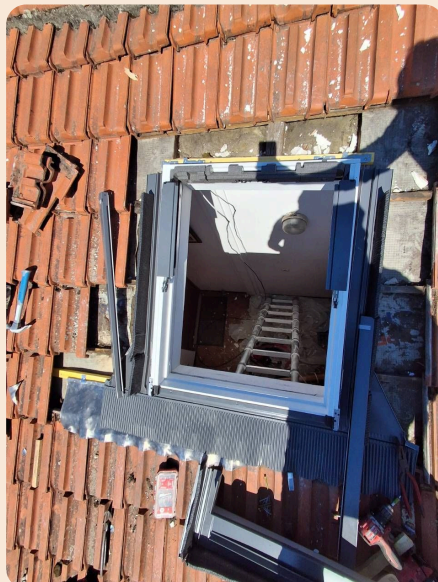
Installation du nouveau Velux
