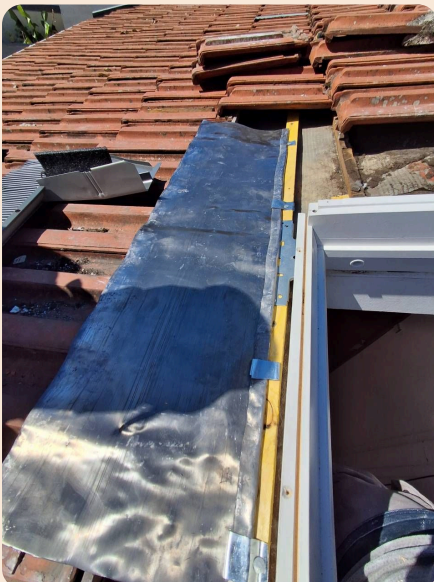
Façonnage pièce en plomb
