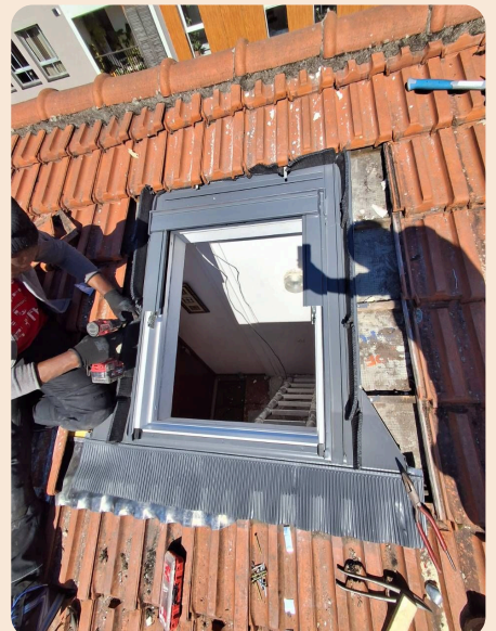
Installation du nouveau Velux
