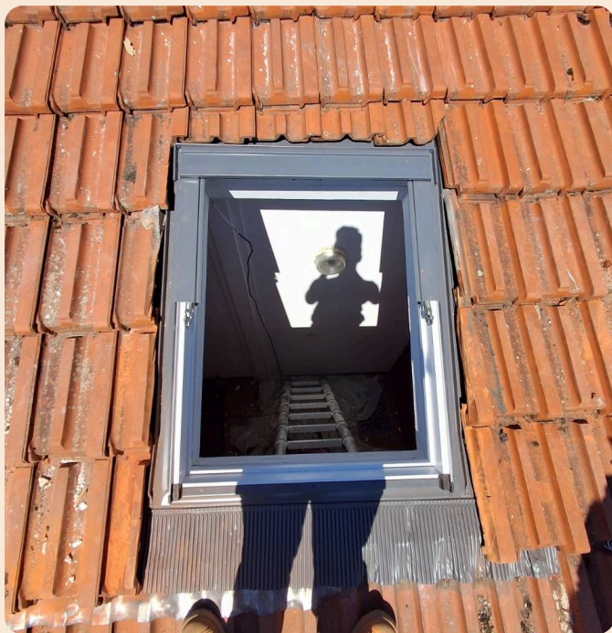
Nouveau Velux posé
