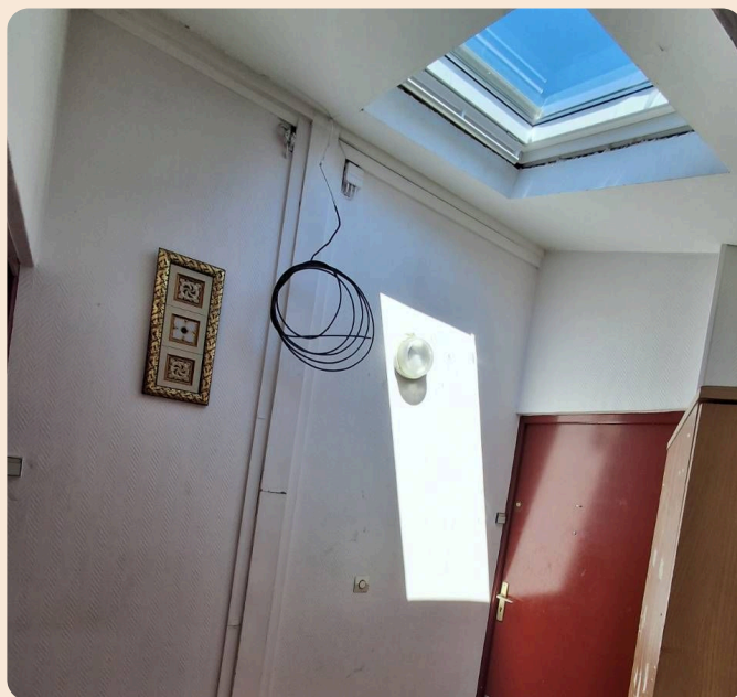
Vue intérieure (avec découpe placo à reprendre).
