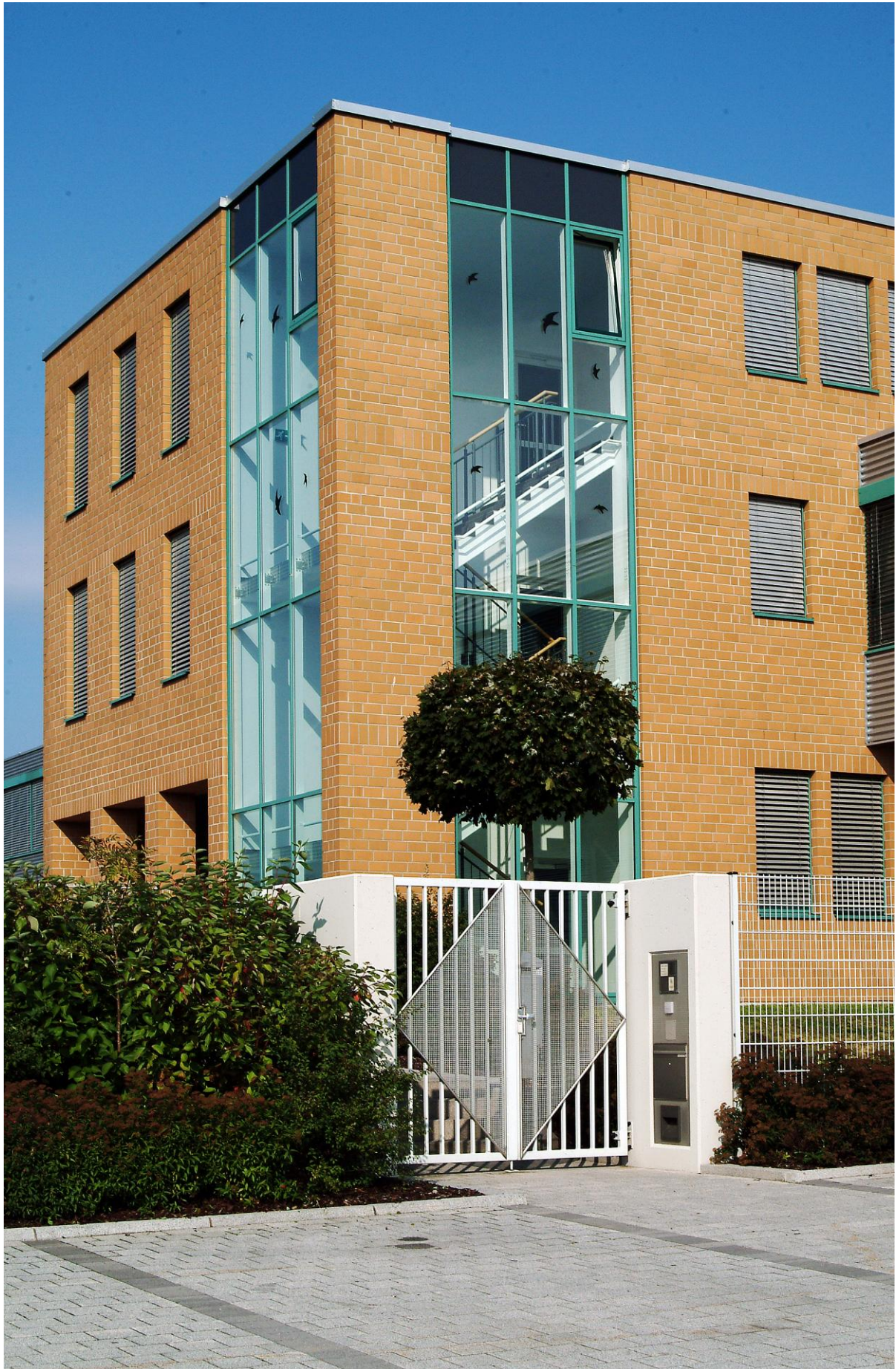
Der Würfelförmiger Mauerwerksbau markiert den Haupteingang.
