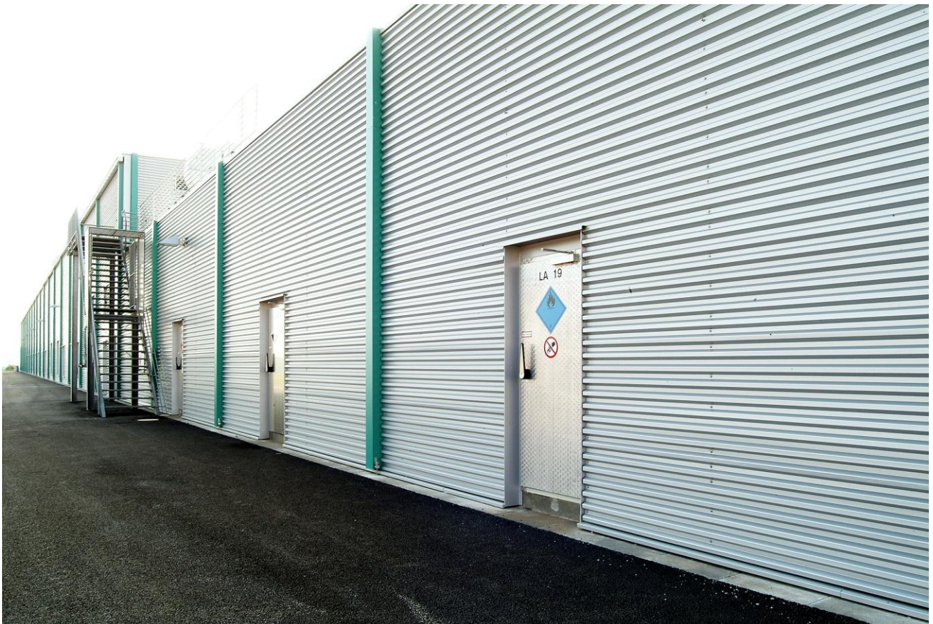
Die Fassadengliederung folgt der modularen Hallenstruktur und macht die abschnittsweise Entwicklung des Standorts ablesbar.
