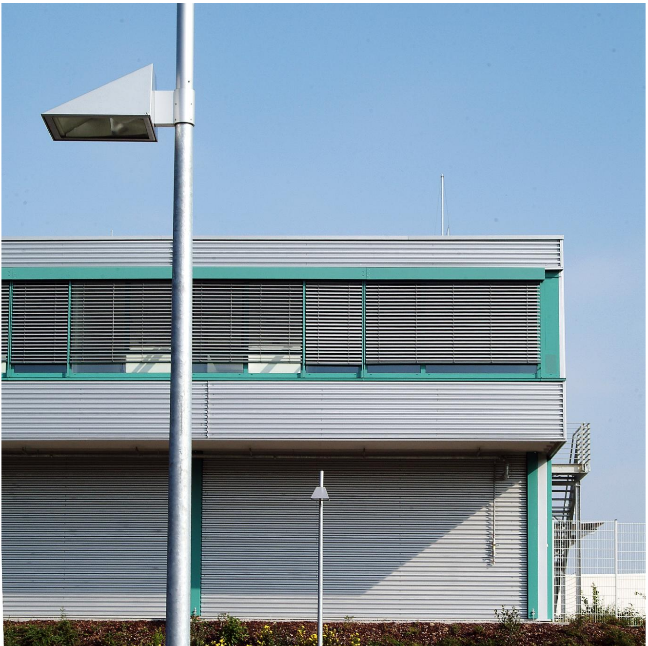
Der vorspringende Verwaltungs- und Büroriegel liefert zugleich eine wirkungsvolle Überdachung für die darunter liegende Be- und Entladezone.
