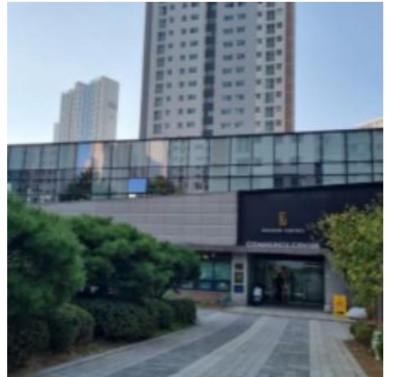
하남미사 부대복리시설 증축공사
