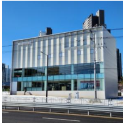
삼성스토어 여주점 신축공사
