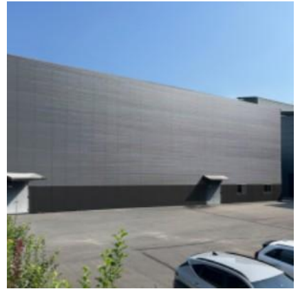
☞코피텍 2동,3동 증축공사
