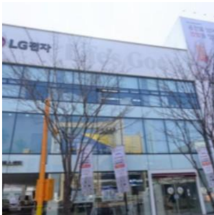
LG베스트샵 양평본점 대수선공사
