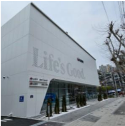
LG베스트샵 대구침산점 신축공사
