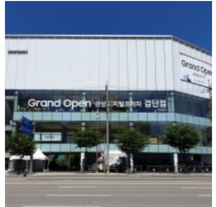
삼성스토어 검단점 신축공사
