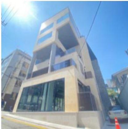
삼성동 근린생활시설 신축공사
