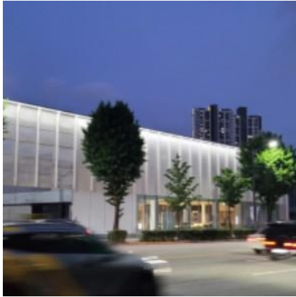
삼성스토어 광천점 대수선공사
