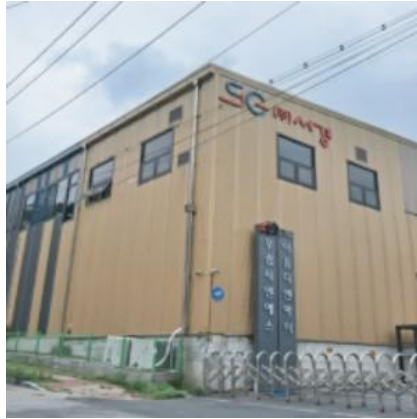
서경에스지 공장 증축공사
