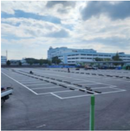
수원 삼성전기 주차장 조성공사
