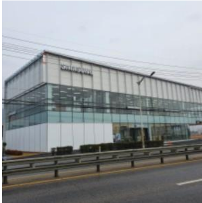
삼성스토어 포천점 신축공사
