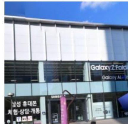
삼성디지털프라자 상봉점 리뉴얼공사
