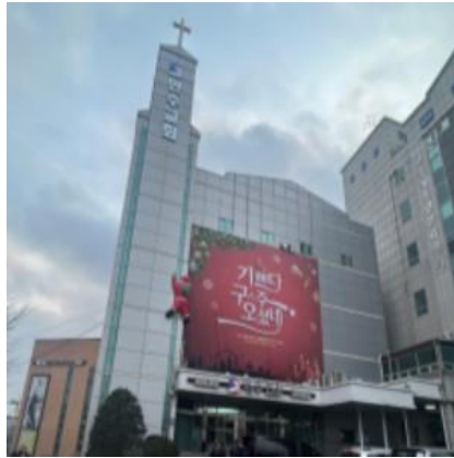
대성전 등 리모델링 공사
