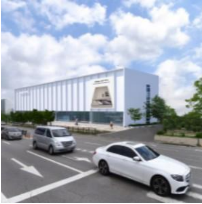
삼성스토어 김포점 신축공사
