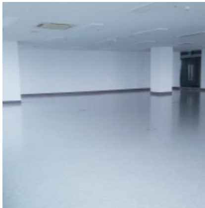
세우빌딩 원상복구 공사
