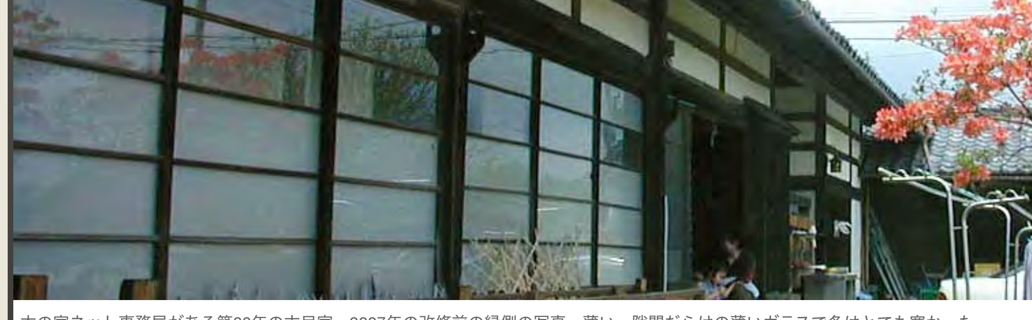
木の家ネット事務局がある築80年の古民家。2007年の改修前の緑側の写真。薄い、隙間だらけの薄いガラスで冬はとても寒かった。
