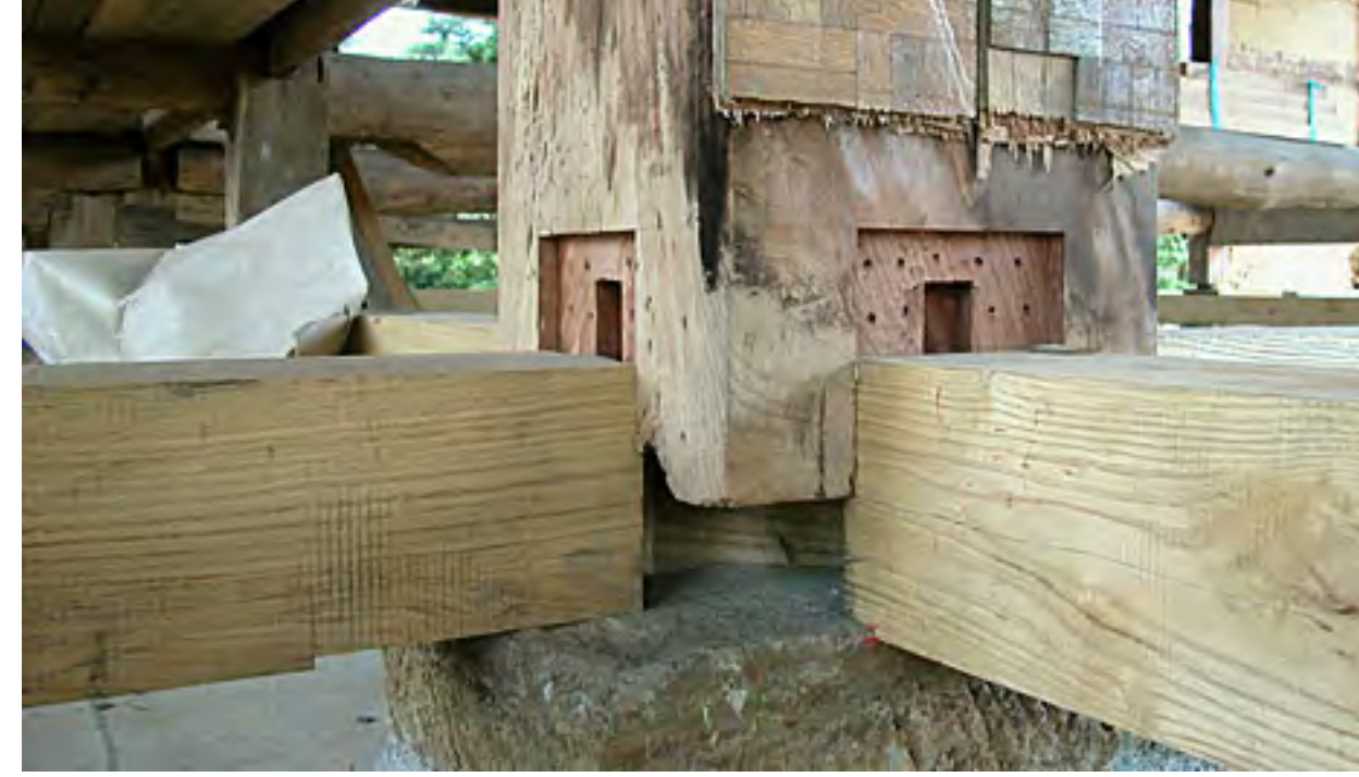
大黒柱の足元を直し、新しい土台に継ぎ直す。基礎はベタ基礎にしたが、基石は古いものをそのまま使っている。
