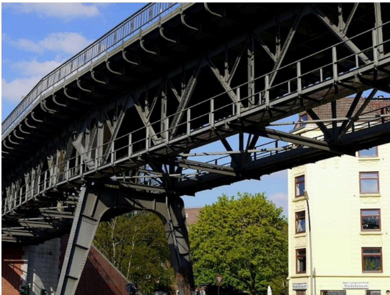
Viadukt in Hamburg Barmbek ( Ctsu / CC BY-SA 3.0)
