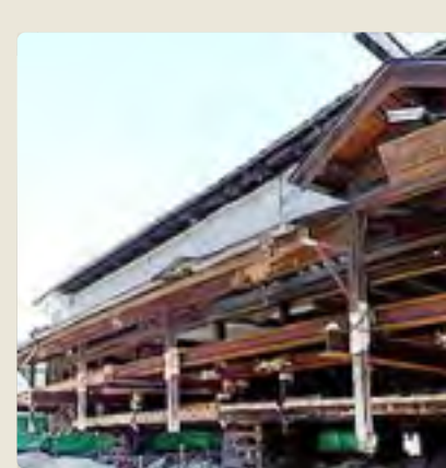
NPO関善賑わい屋敷・曳家工事：この家が動く！
