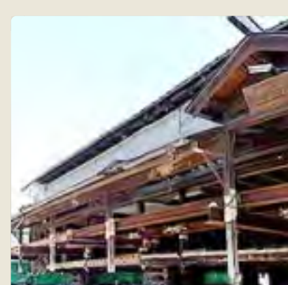
NPO関善賑わい屋敷・曳家工事：この家が動く！
