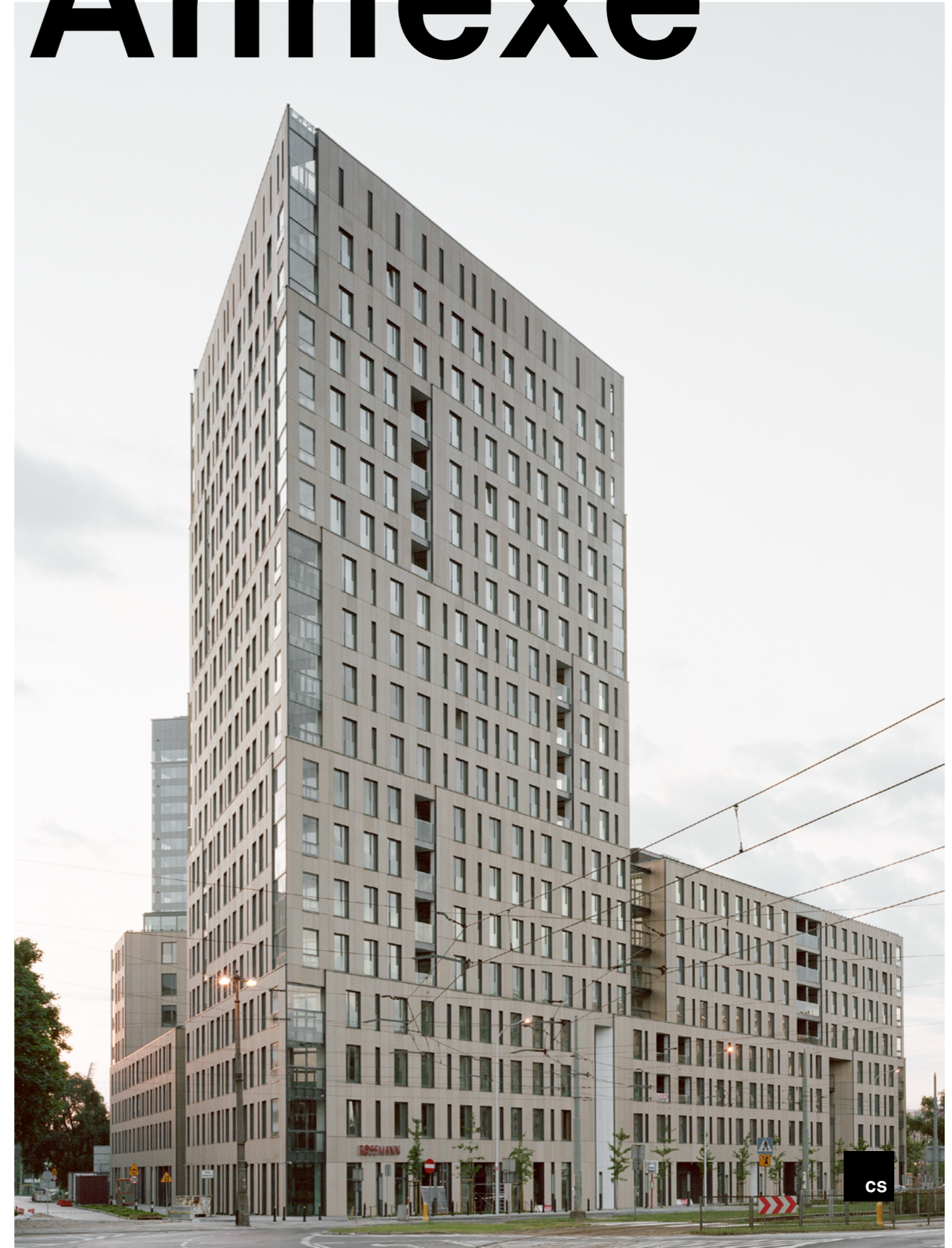
Immeuble d'habitation Trio, Varsovie, Pologne | JEMS Architectes
