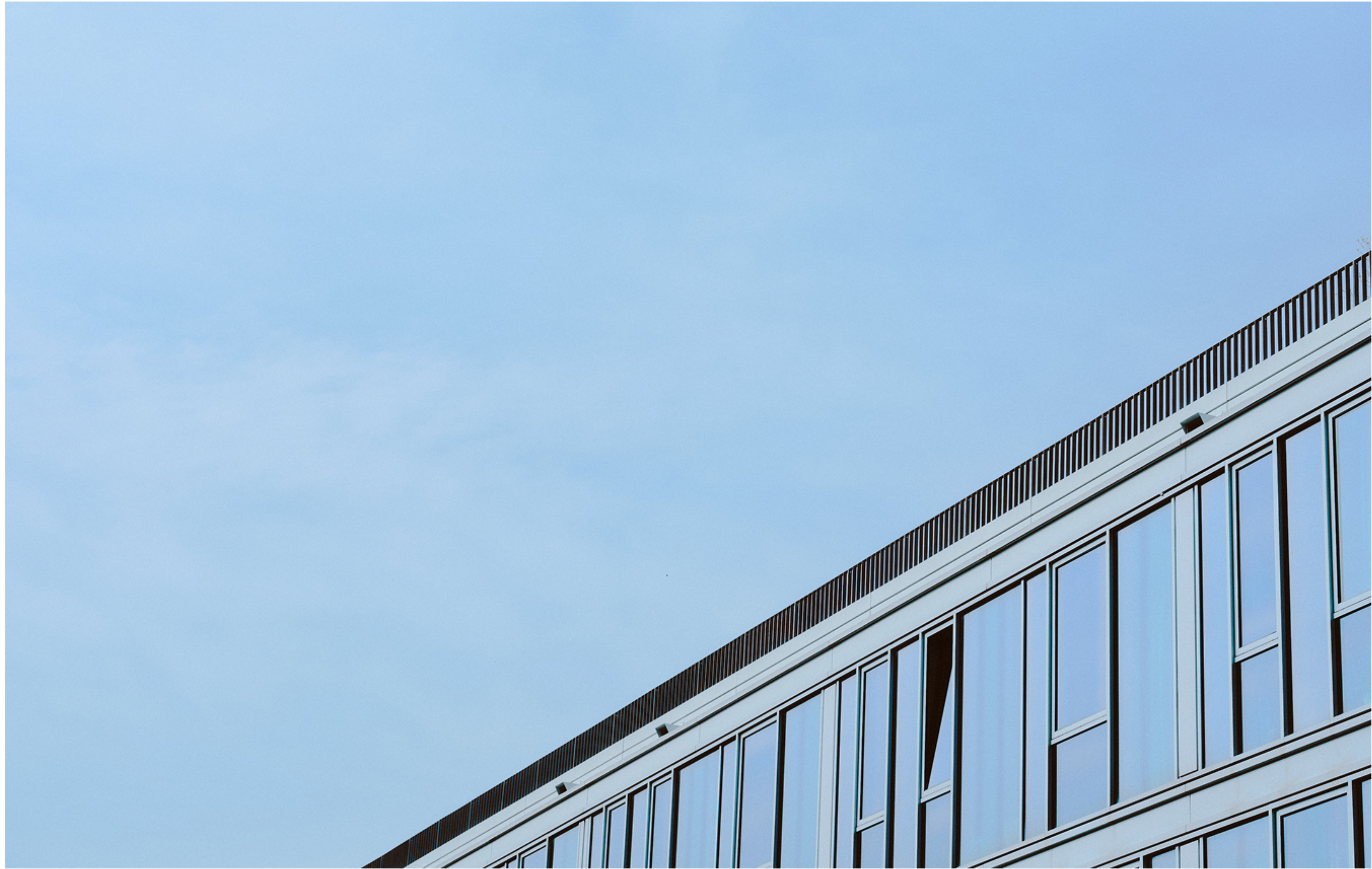
(1) Blick aus dem Innenhof hoch
