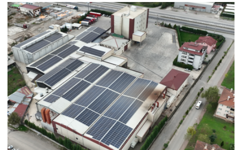
Durak Fındık - Sakarya/ Hendek Kırma Fabrikası
