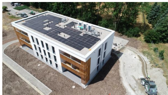
Gebäudeansicht mit PV-Dach
