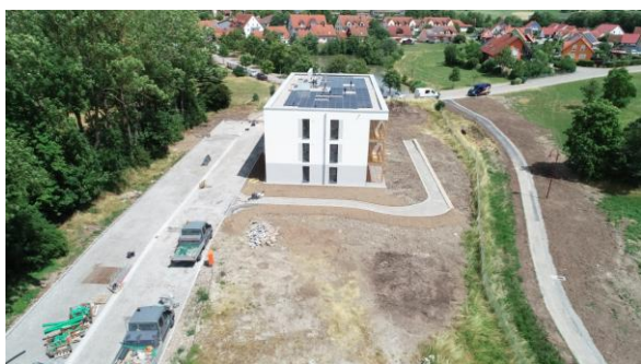
Dachfläche mit PV-Anlage und Holzfassadenelementen
