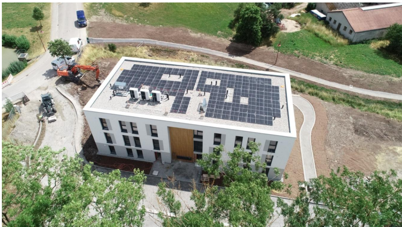
Dachaufsicht mit Photovoltaikanlage und technischer Ausstattung
