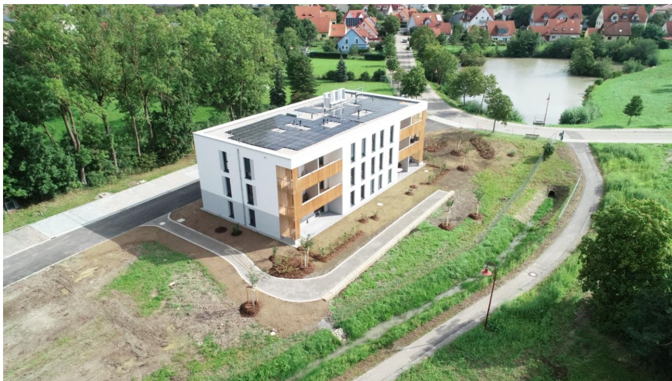
Fertiggestelltes Mehrfamilienhaus am Dorfsee mit Photovoltaikanlage und Außenanlagen
