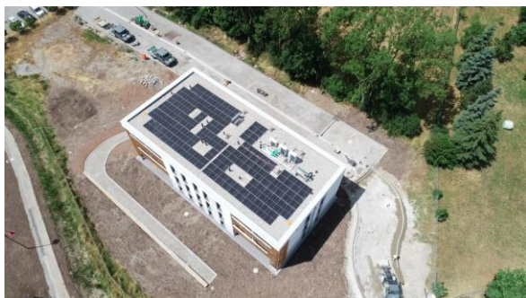
PV-Dachaufsicht und Baumfeld
