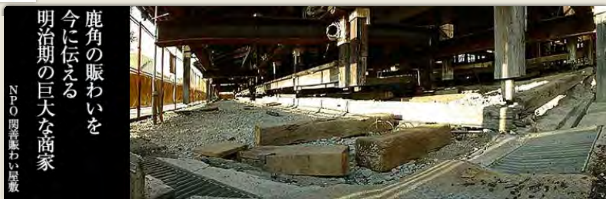
宙に浮いた関善酒店のコミセ部分。土台から柱が抜けているのがわかる。
