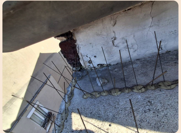
Zone au dessus de l'appartement du 1 er étage d'infiltration probable apparente sur la gauche
