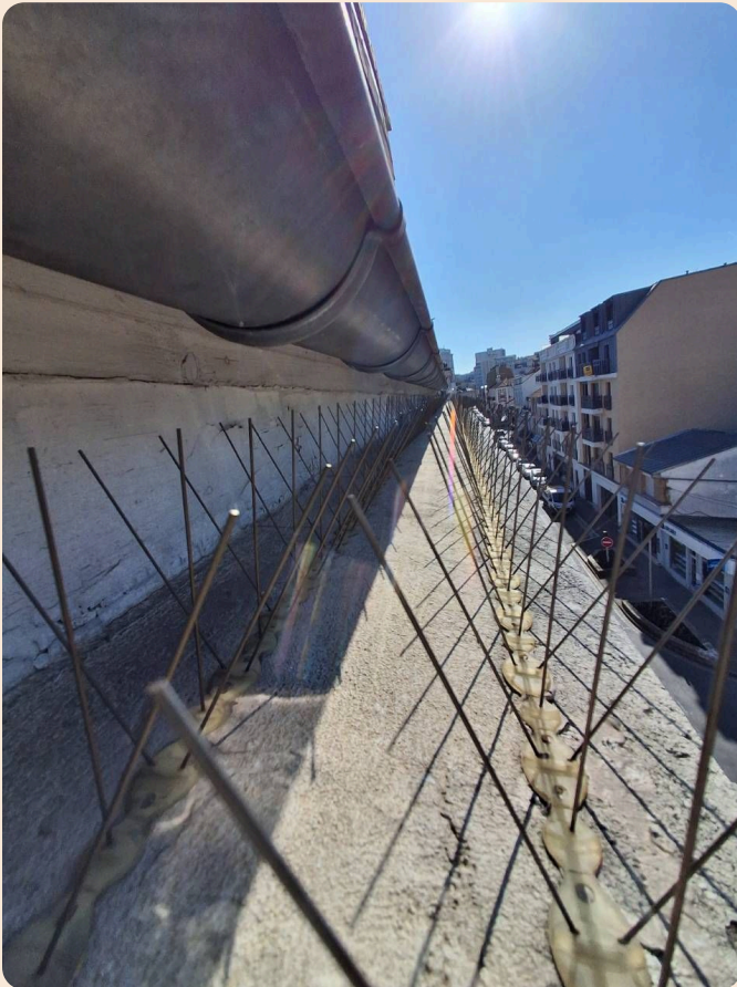
Zone au dessus de l'appartement du 1 er étage d'infiltration probable apparente sur la gauche
