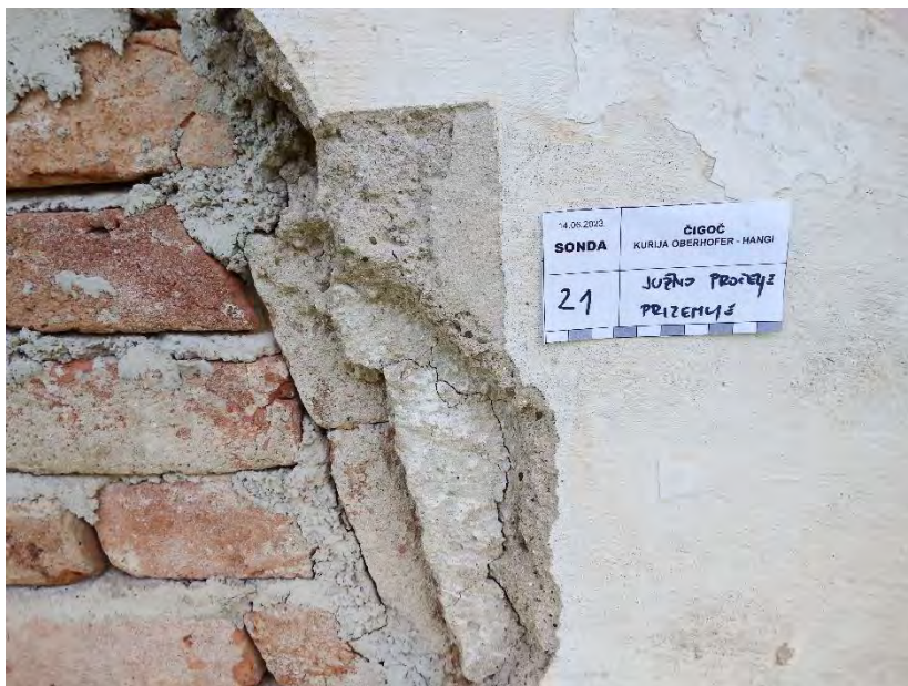
Sonda 21, dvoslojno nanošenje žbuke
