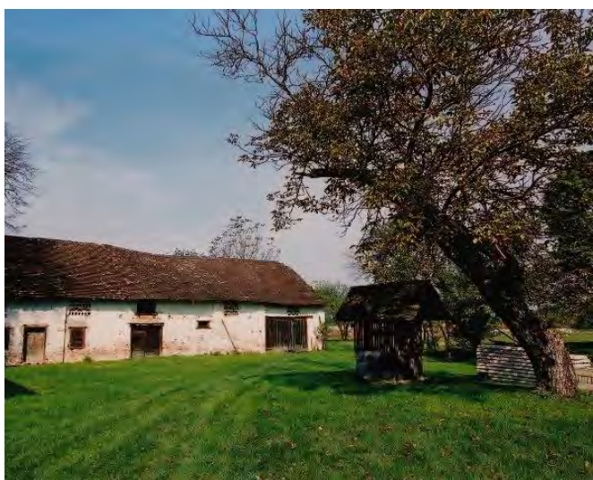
Sl. 29. Gospodarska zgrada, prije 1998. godine
