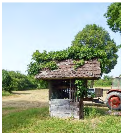
Sl. 68. Bunar s krunom od hrastovih planki i sačuvanim povijesnim mehanizmom
