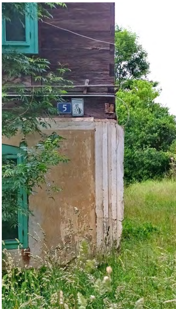
Sl. 73. Detalj ugaonog pilastra s kanelirama
