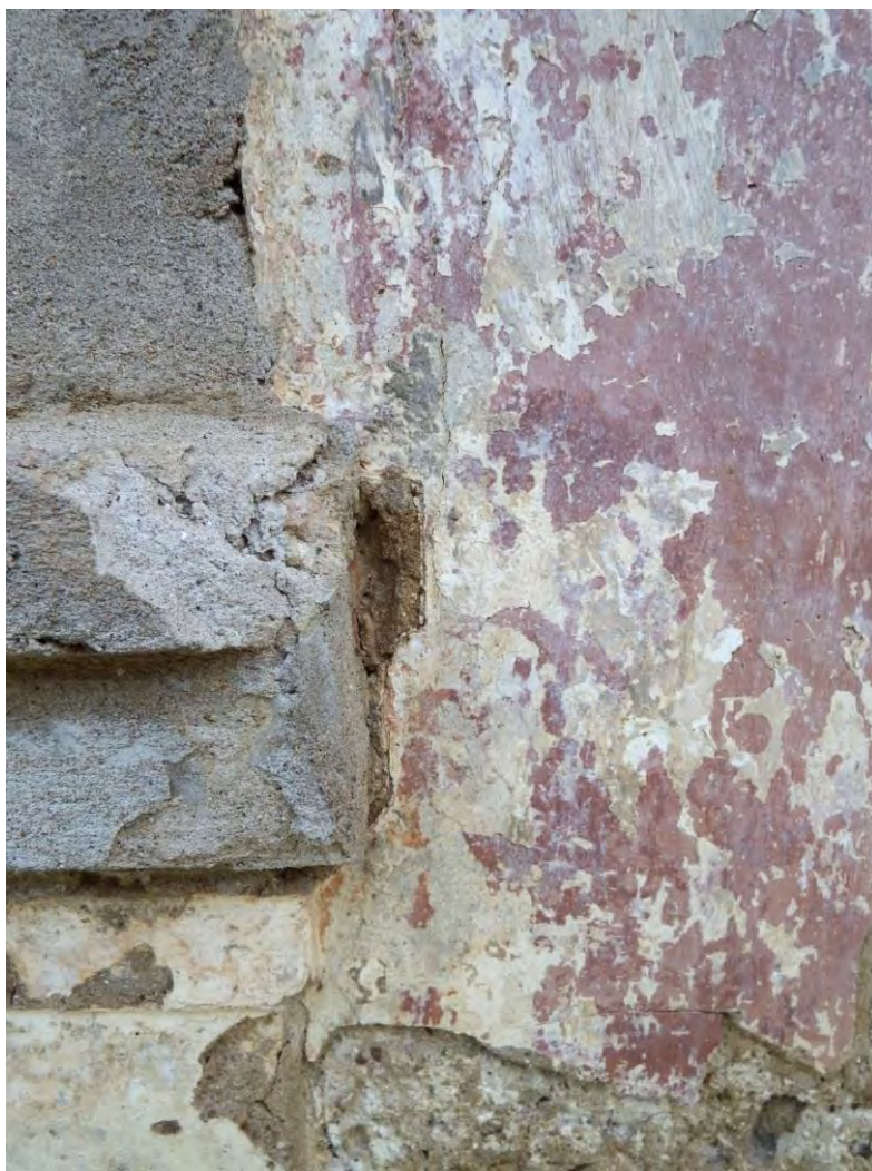
Sonda 22, detalj s otiskom starije profilacije kapitela (uz zapadni pilstar)
