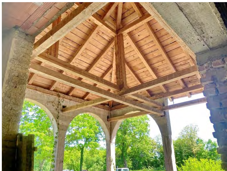
Sl. 45. Konstrukcija nadstrešnice terase
