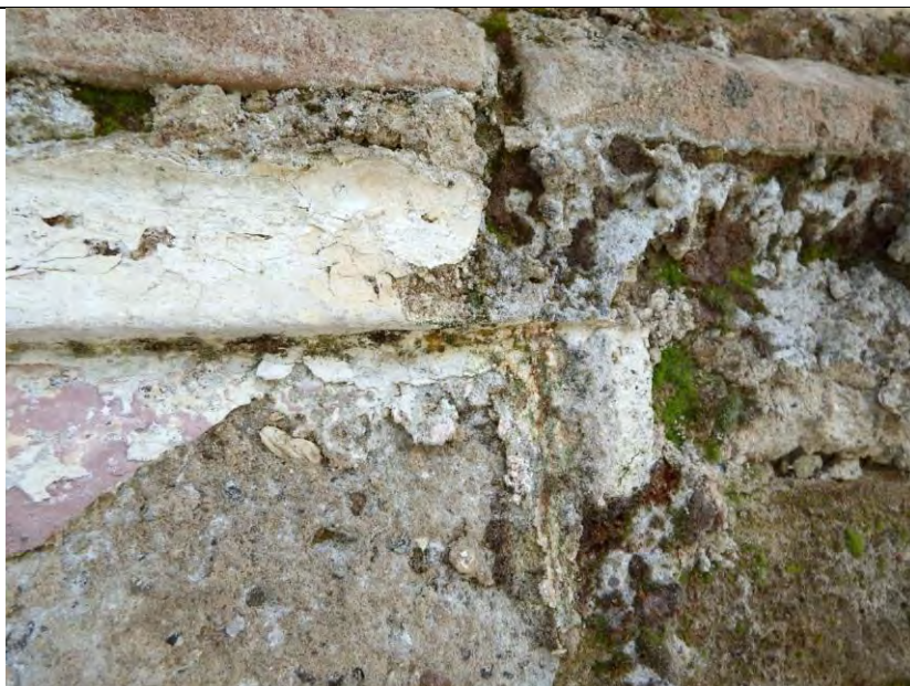
Sonda 22, detalj žbukanog ruba uz polje iznad kapitela
