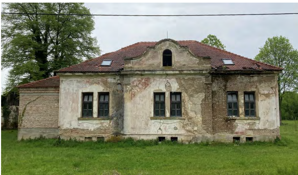
Sl. 35. Južno (ulično) pročelje
