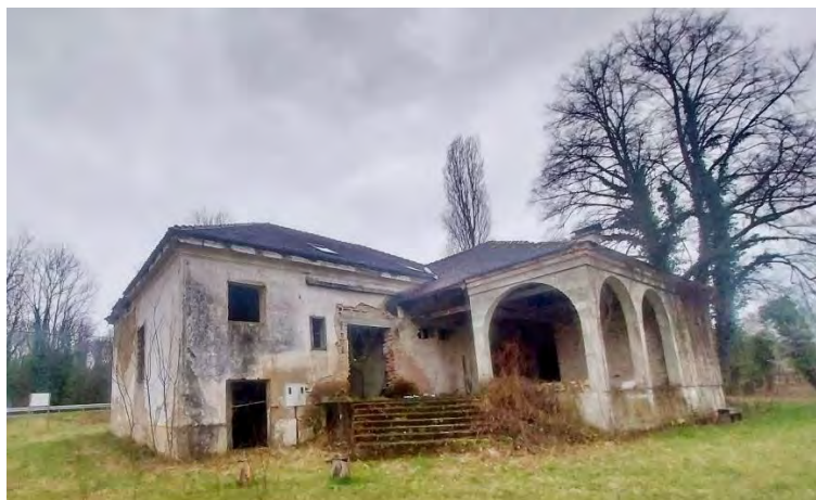
Sl. 41. Pogled na sjeverno (dvorišno) pročelje
