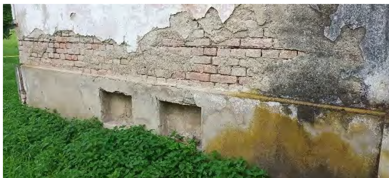
Sl. 37. Detalj oblikovanja podnožja na južnom pročelju
