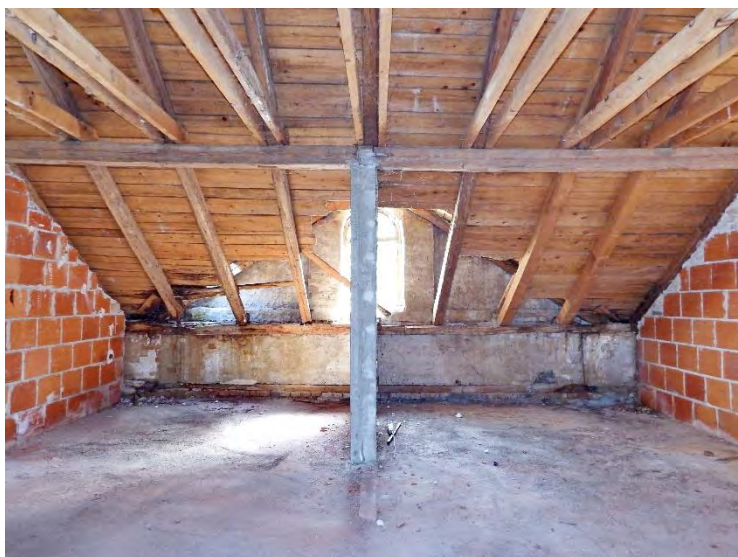
Sl. 61. Potkrovlje, prostor atike –pogled prema prozoru
