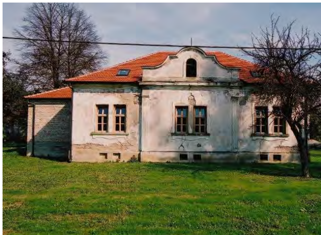
Sl. 25. Ulično (južno) pročelje, nakon 1998. godine
