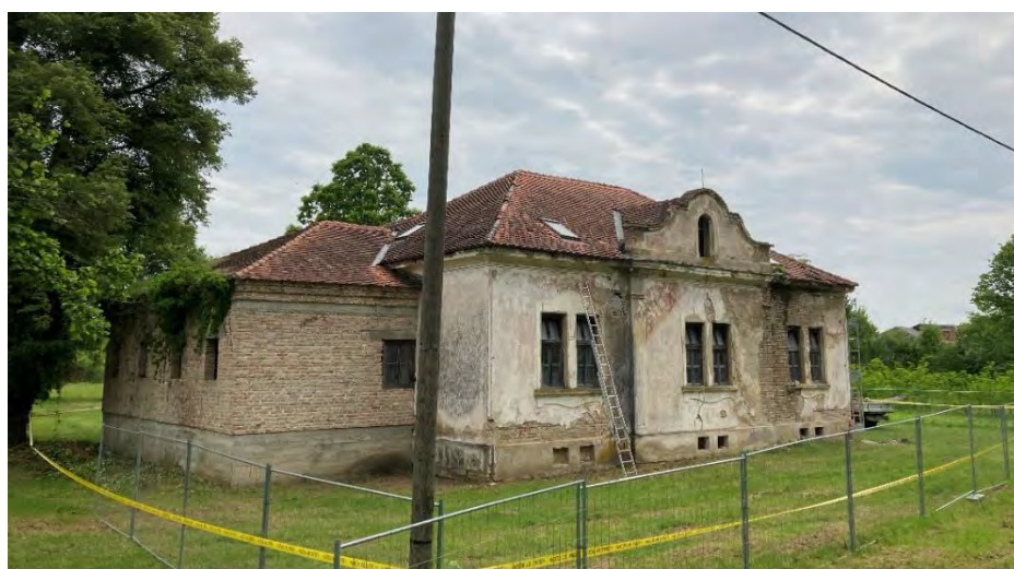
Sl. 33. Pogled na južno i zapadno pročelje
