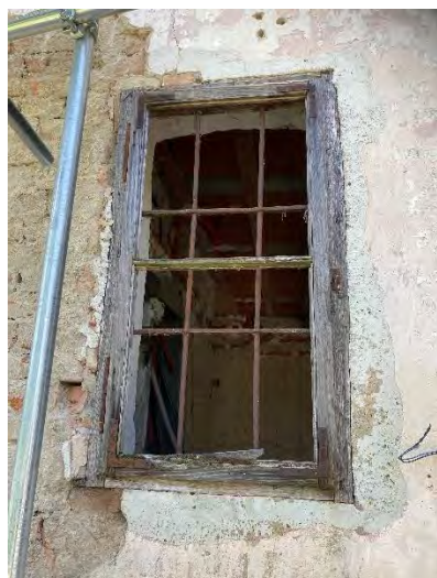
Sl. 43. Mali prozor na sjevernom pročelju
