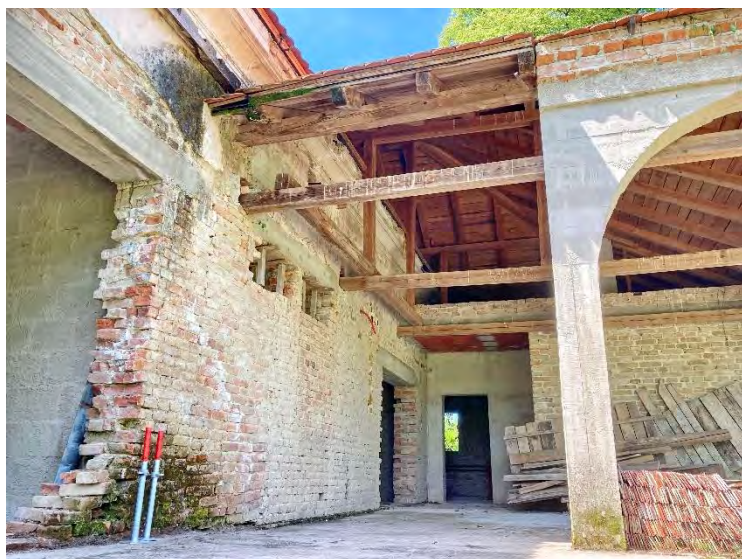
Sl. 44. Pogled na sjeverno pročelje, terasu i zapadni ulaz
