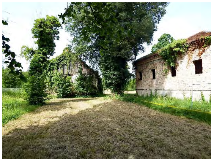
Sl. 67b. Gospodarska zgrada, južno pročelje
