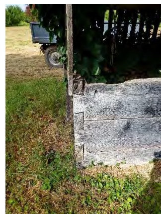
Sl. 68. Bunar s krunom od hrastovih planki i sačuvanim povijesnim mehanizmom
