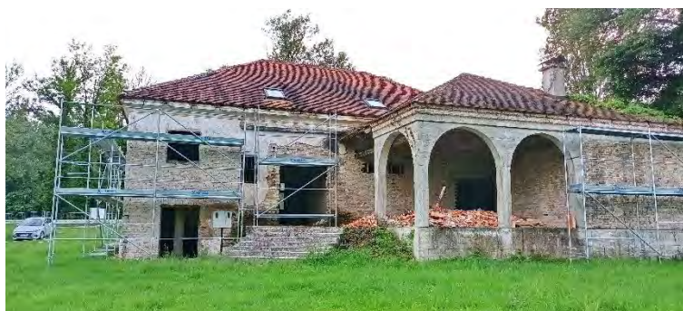
Sl. 42. Pogled na sjeverno (dvorišno) pročelje
