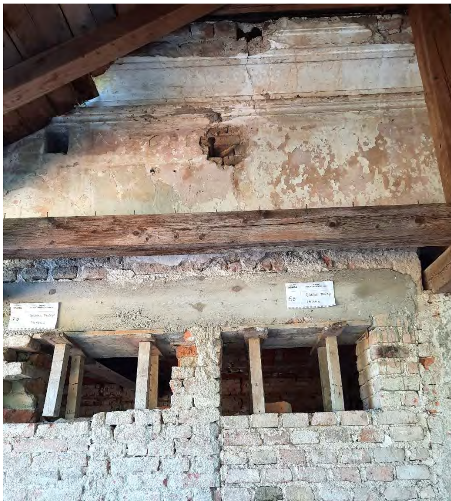
Sonda 31 – otisak grede s kovanim čavlom u natkrivenom trijemu, prije današnje terase
