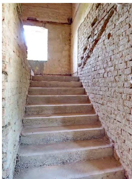
Sl. 55. Novosagrađeni stubišni krak između prizemlja i potkrovlja, P5
