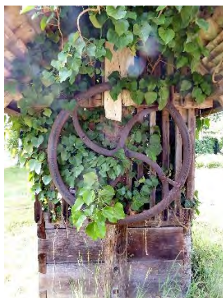
Sl. 68. Bunar s krunom od hrastovih planki i sačuvanim povijesnim mehanizmom
