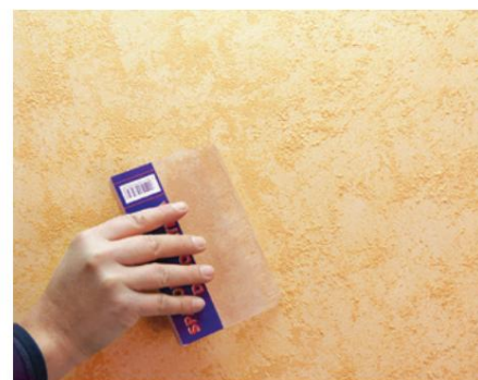
Al doilea strat cu spatulă specială cu lamă dublă cod 1016
