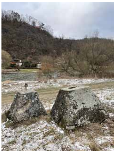
Betonové patky bývalého elektrického vedení
