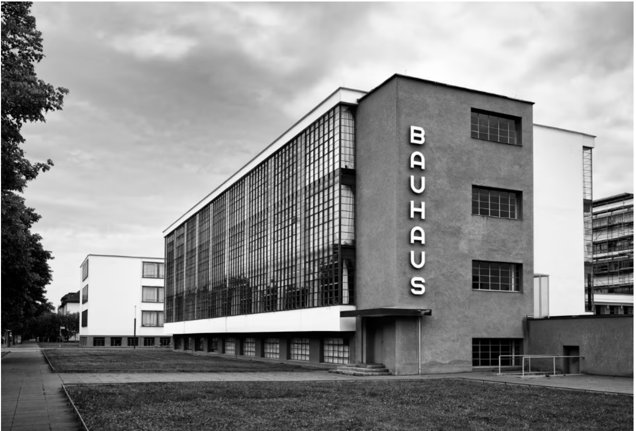
L'edificio della scuola del Bauhaus, Dessau Germania, Walter Gropius (1925 - 1926)
