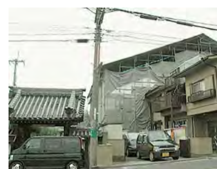
大阪府大東市の町中にある瑞玄寺の改修工事をしている。ご住職による「本堂改修ブログ」で改修工事の日々の様子が分かる。
