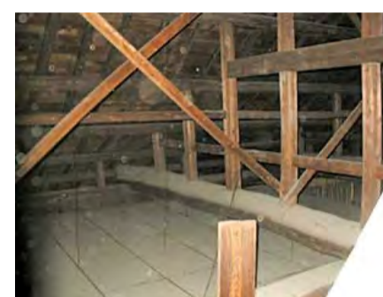
天井を見上げた時とはまったく違う、小屋裏の様子。
