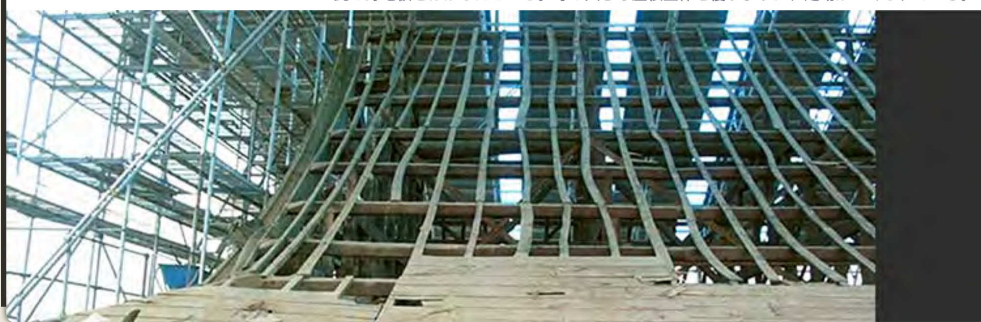
瓦と野地板をはがしたところ。寺の大きな屋根全体を覆うように、足場がつくられている。
