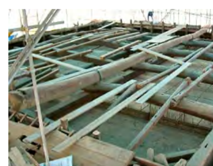
古い松の梁を再利用するために、桁の上におろしてきたところ。
