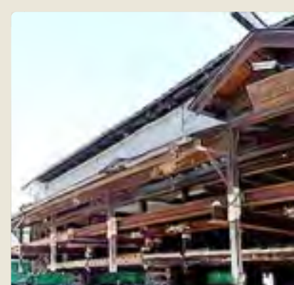
NPO関善賑わい屋敷・曳家工事：この家が動く！
