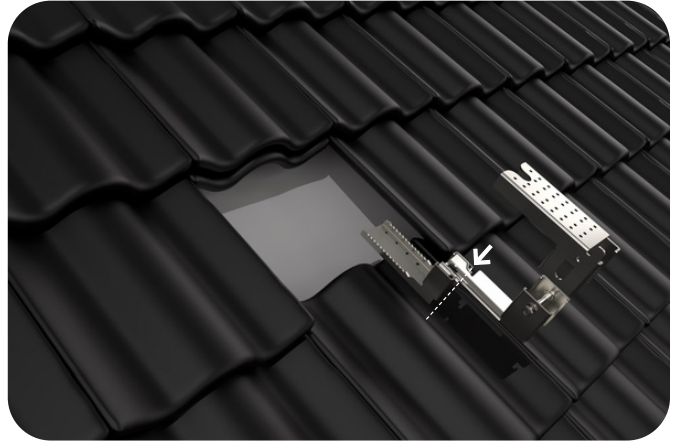
2. Sätt bultskruv i fästet.
