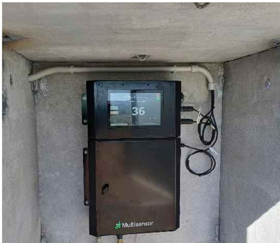
Sensor MS2000 para la determinación de THMs en el depósito La Anchosa (Lorquí)
