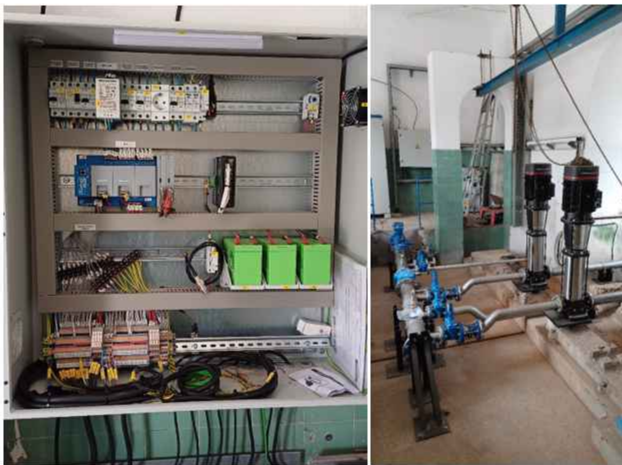
Ilustración 51. Nuevo Cableado instalado y caudalímetro electromagnético
