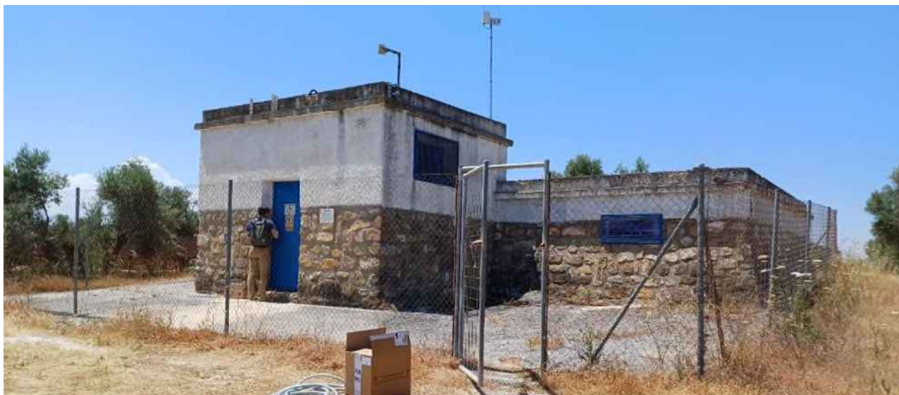
Ilustración 45. Imagen exterior depósito Santa Eulalia
