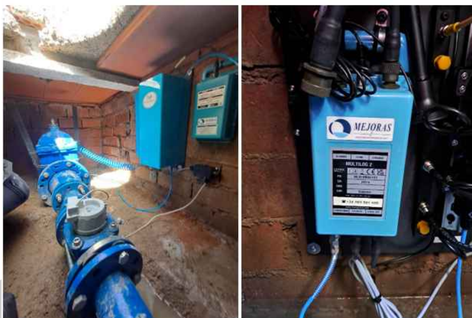
Ilustración 73. Instalación de Registrador de Datos y sensórica
