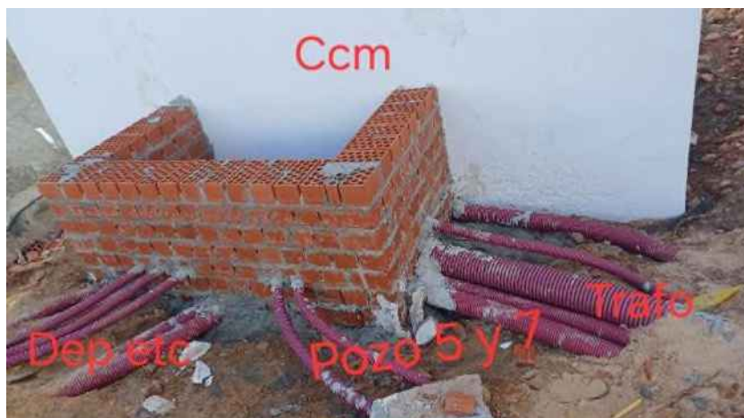
Ilustración 19. Nuevo cableado de señal y fuerza desde nuevo CCM hasta las bombas, depósito y Transformador
