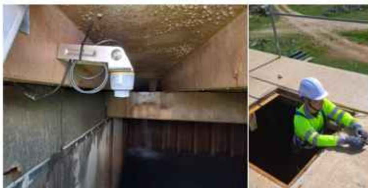
Ilustración 24. Remota instalada en pozo Valparaíso y operario trabajando en el servicio de Villarrubia de los ojos
