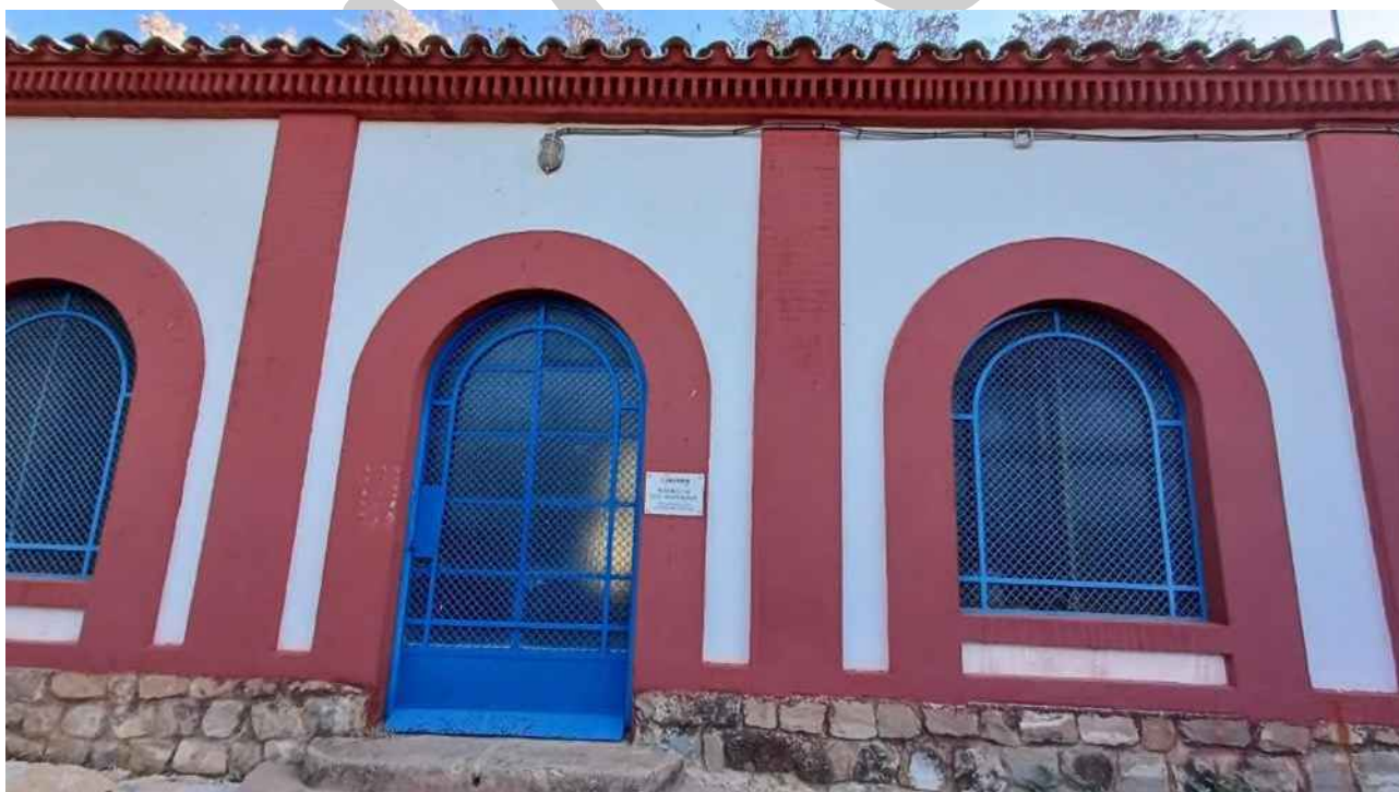
Ilustración 50. Imagen Exterior Bombeo San Bartolomé
