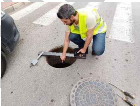
Ilustración 3. Personal propio realizando trabajos de medición.
