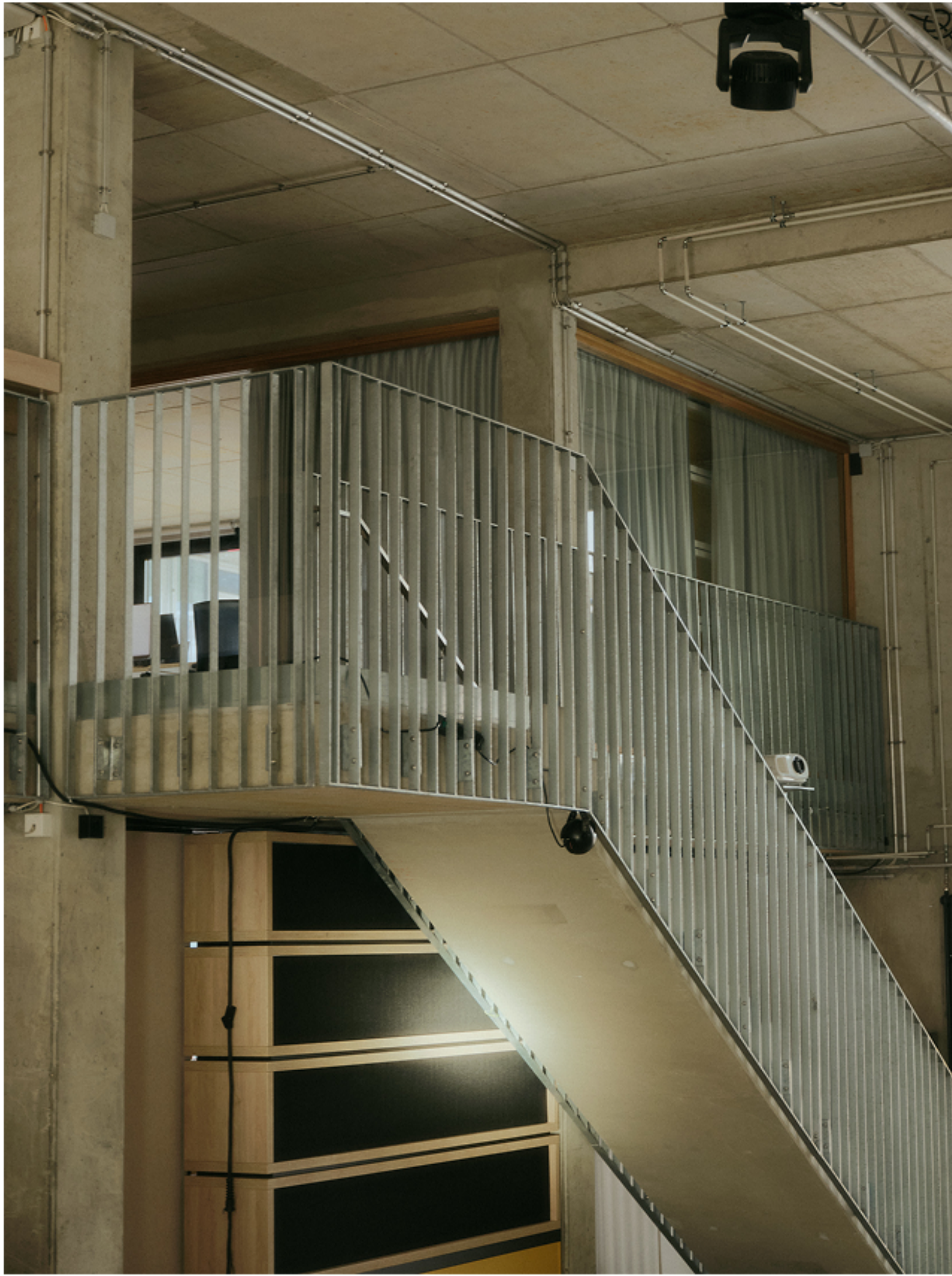
(5) Treppe zur 1. Etage
