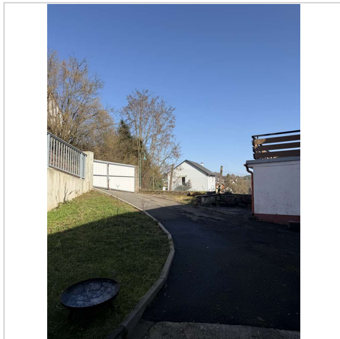
Einfahrt Rückansicht Gebäude
