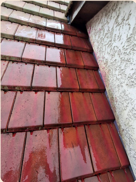
Test UV fluorescent pour confirmer la mise hors d'eau
