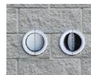
Afsluitklep voor in- en uitlaat
