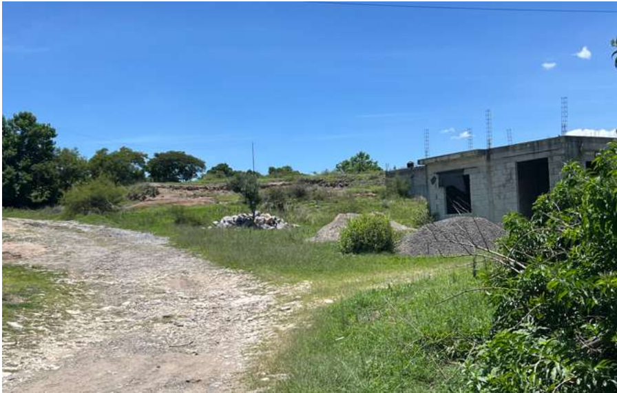
Recorrido del sitio por el costado Este.
