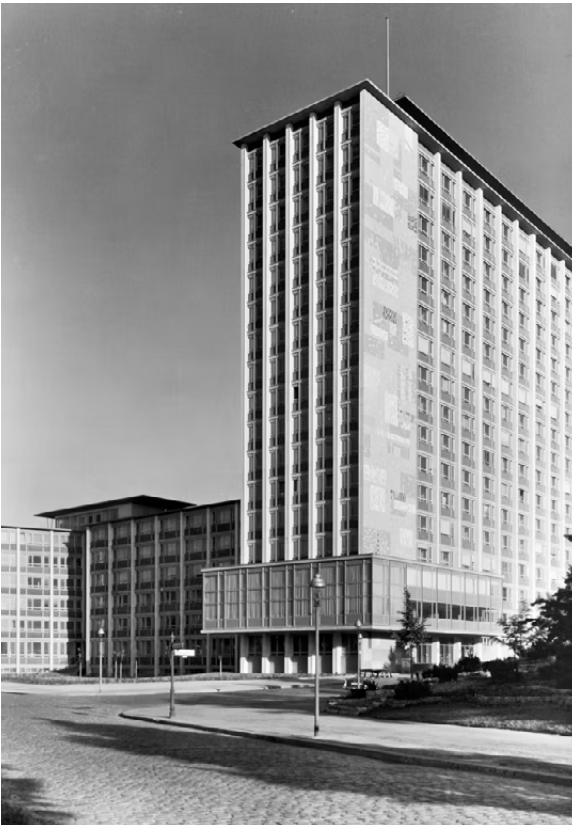
Senatsverwaltung für Bau- und Wohnungswesen, errichtet 1954 - 1956; Bild: Landesarchiv Berlin, F Rep. 290 (06) Nr. 0167396 / Foto: Otto Hagemann
